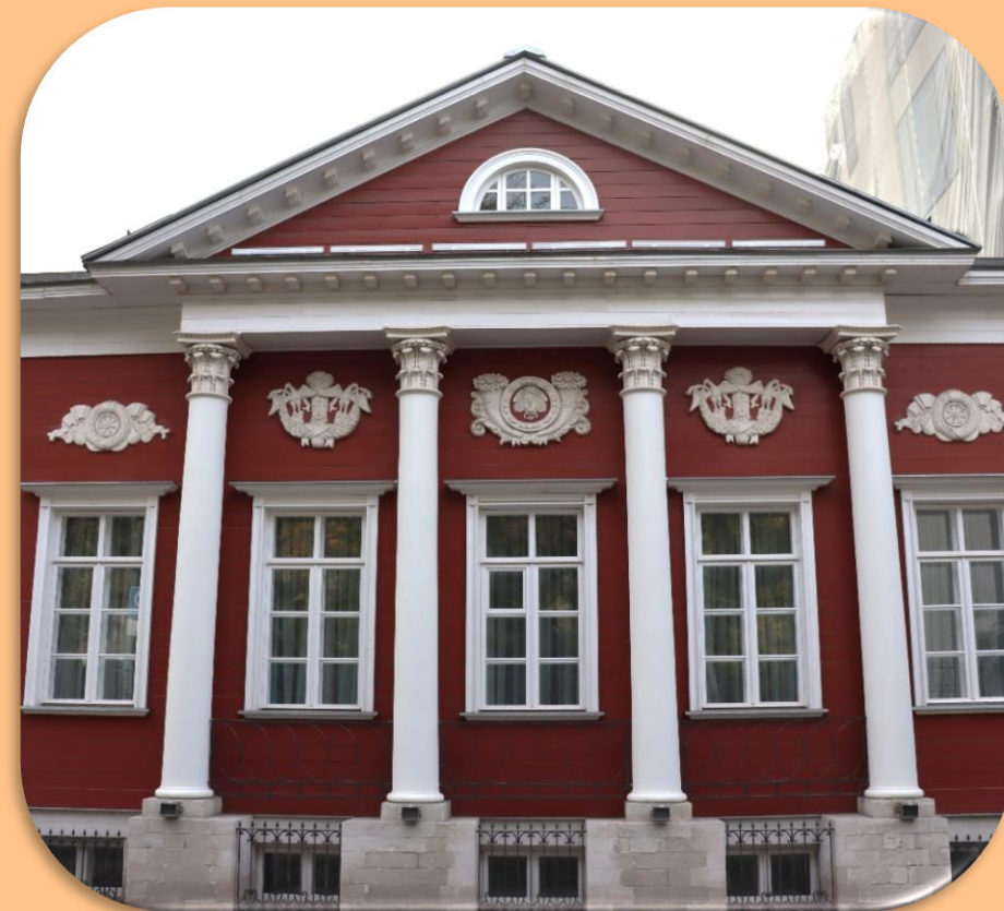
Четырехколонный коринфский портик фасада
