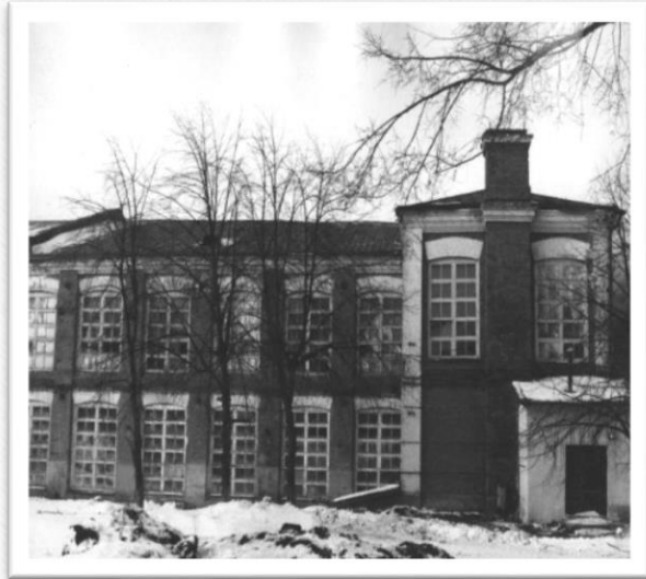
Ткацкая фабрика. корпус № 6. Восточный фасад
